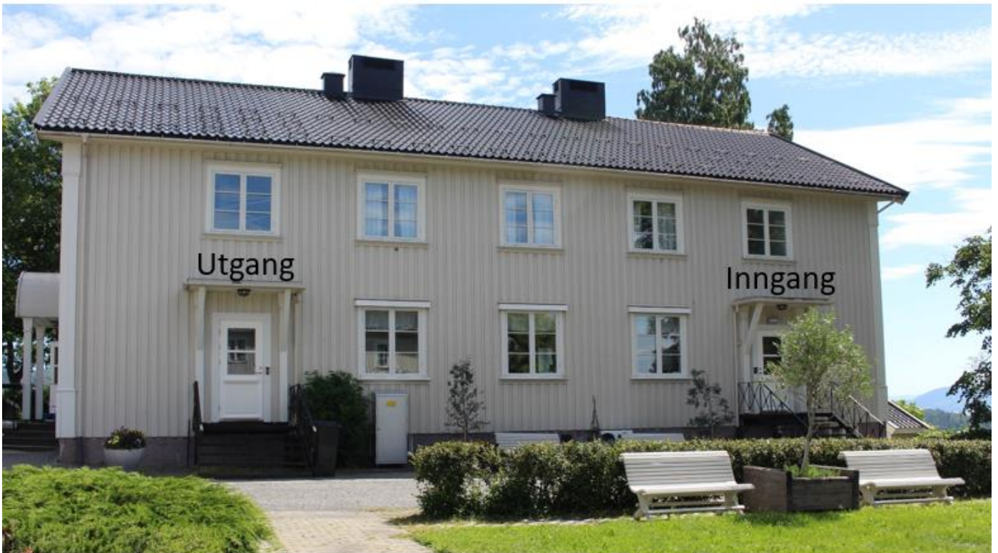
Fra studiestart høsten 2024 kan vi invitere til en oppusset kantine med nye rutiner. Benytt inngang nærmest Mjøsa og utgang ut mot tunet, så vil serveringen gå raskere. Foto: Dorte Finstad
